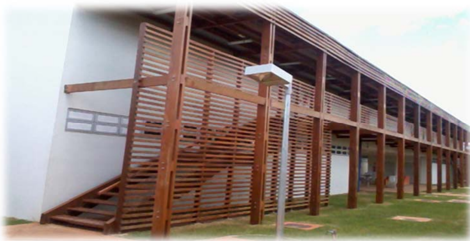
Foto7: Fachada externa do prédio do alojamento da LEdoC 13
