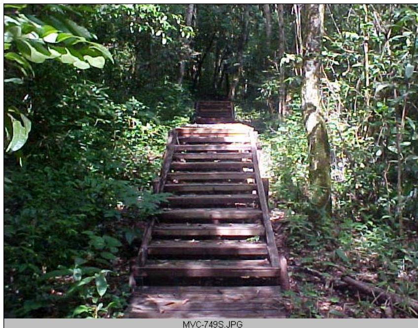
Escada em madeira
