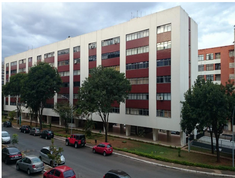
Imagem 6 - Prédios Residenciais Típicos de Brasília
