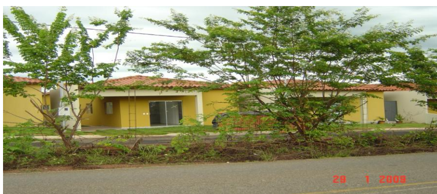
Ilustração 7. Chalés recém construídos perto do aeroporto.
