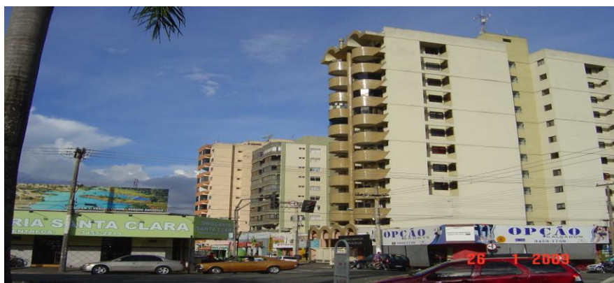
Ilustração 6. Edificações erguidas no centro da cidade.
