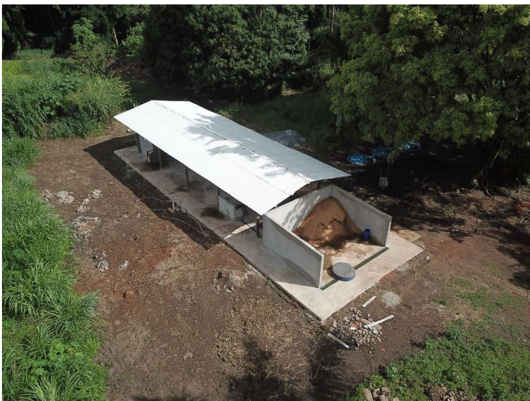
Figura 6: Área de Recebimento e Mix de Resíduos e Galpão de Lavagem e Secagem de Bombonas do Pátio de Compostagem Jardins Romero Melo em maio de 2018. Fonte: Acervo Pessoal Hugo Vale.
