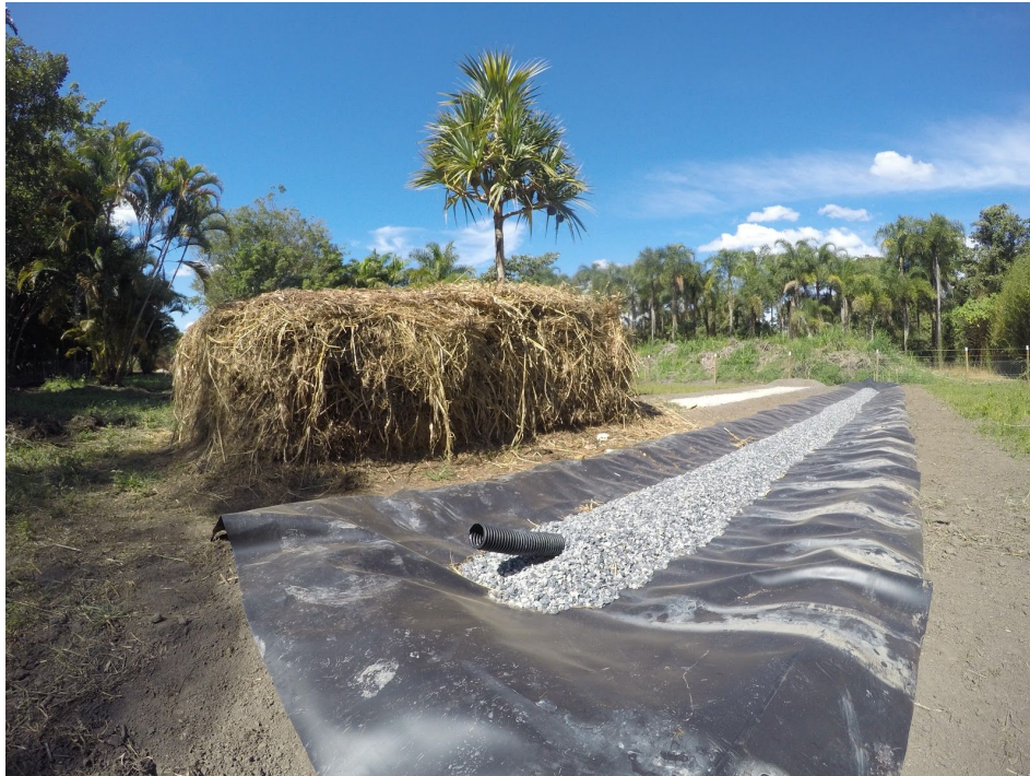
Figura 10: Em primeiro plano, camada de impermeabilização do solo, coleta e drenagem de percolado, e em segundo plano leira de compostagem em funcionamento no Pátio de Compostagem Jardins ROmero Melo em Maio de 2018. Fonte: Acervo Pessoal Hugo Vale.
