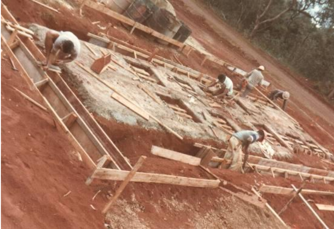
Figura 19 - Construção dos alicerces do Portão Principal do Jardim Botânico de Brasília, (fotografia de Georges Lodygenski).
