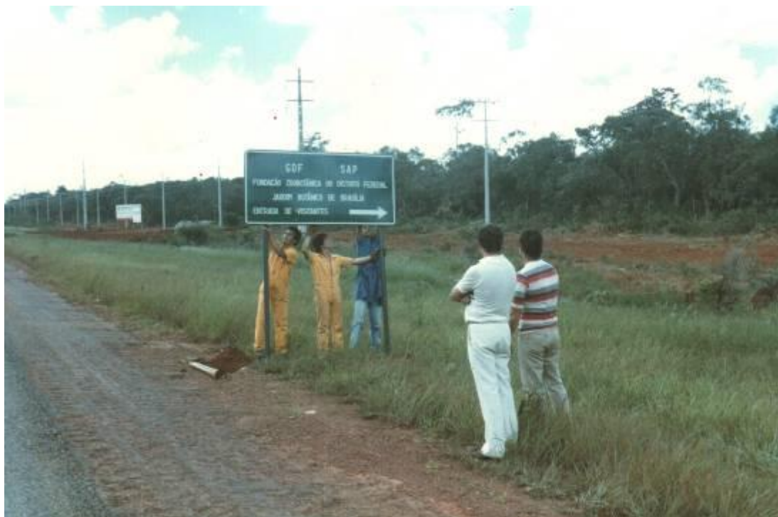
Figura 23 - Instalação da sinalização externa ao Jardim Botânico de Brasília.
