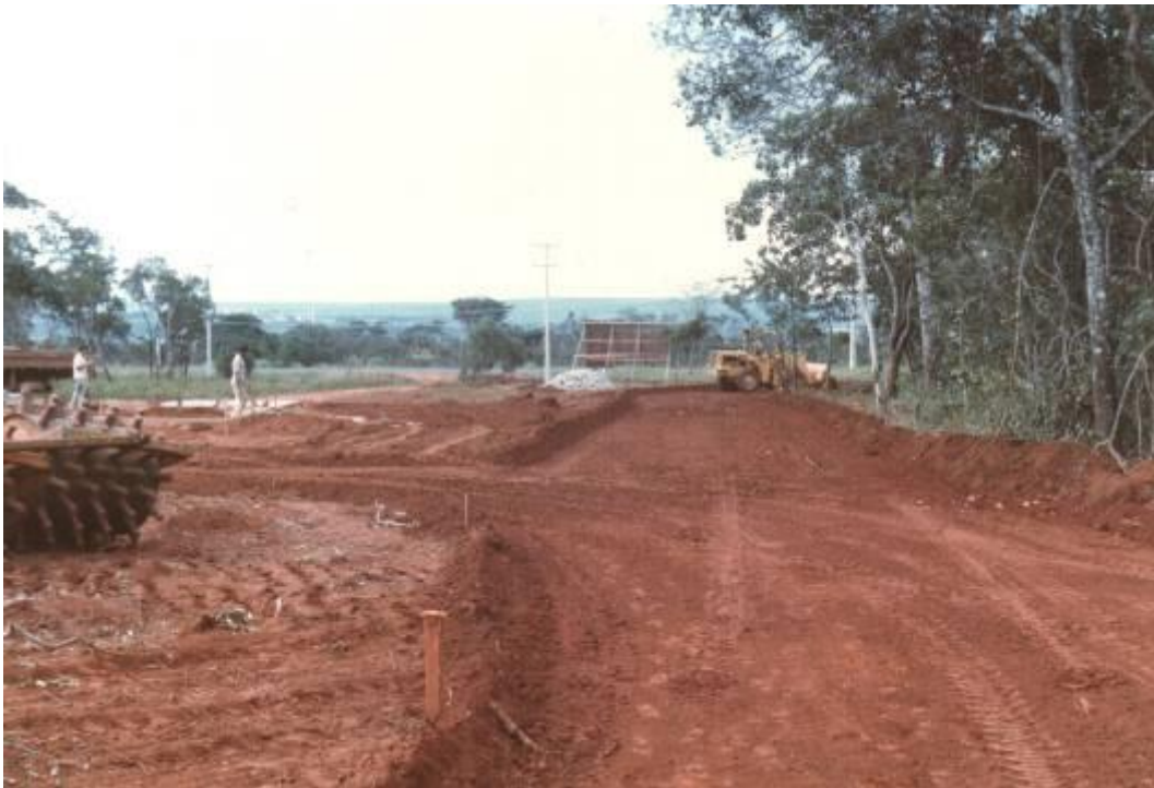
Figura 20 - Construção das vias de circulação do Portão Principal do Jardim Botânico de Brasília (Fotografia de Georges Lodygenski).
