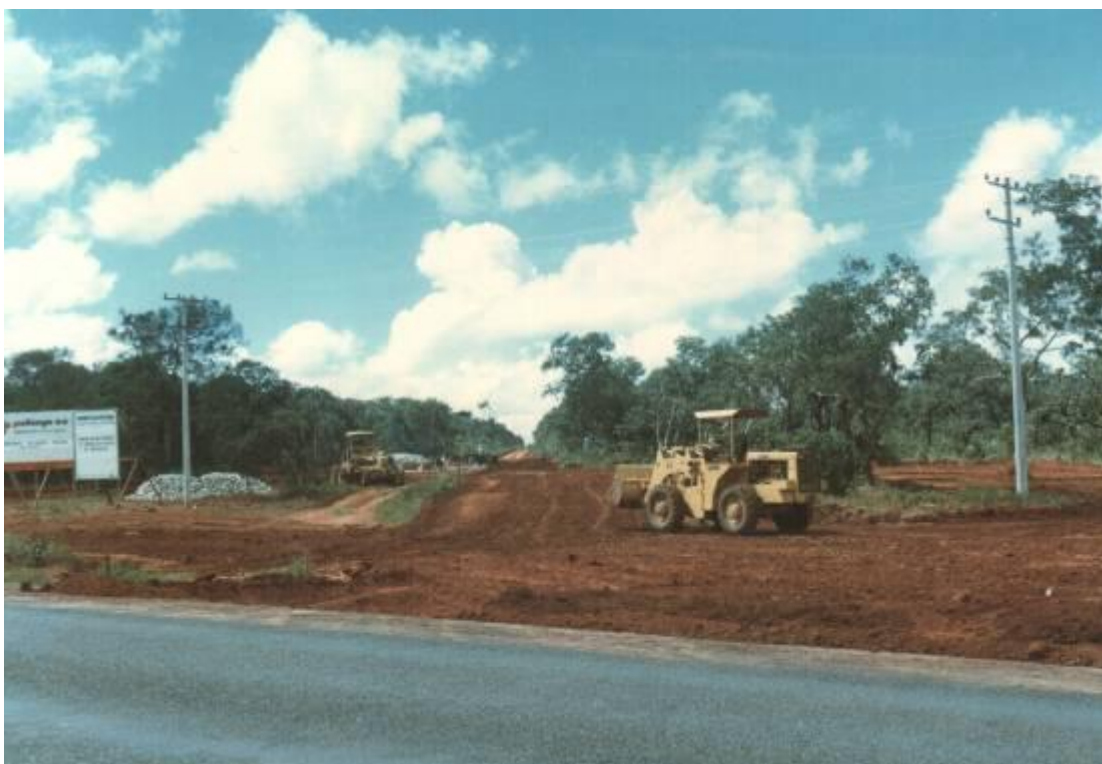
Figura 18 - Início da construção do Portão Principal do Jardim Botânico de Brasília. (fotografia de Georges Lodygenski).
