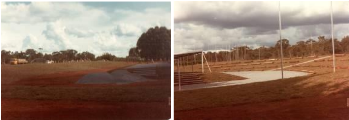
Figura 41 - Construção do Anfiteatro da Alameda das Nações e dos Estados do Jardim Botânico de Brasília (Projeto e fotografia de George Lodygenski; toldo em montagem para solenidade de inauguração).
