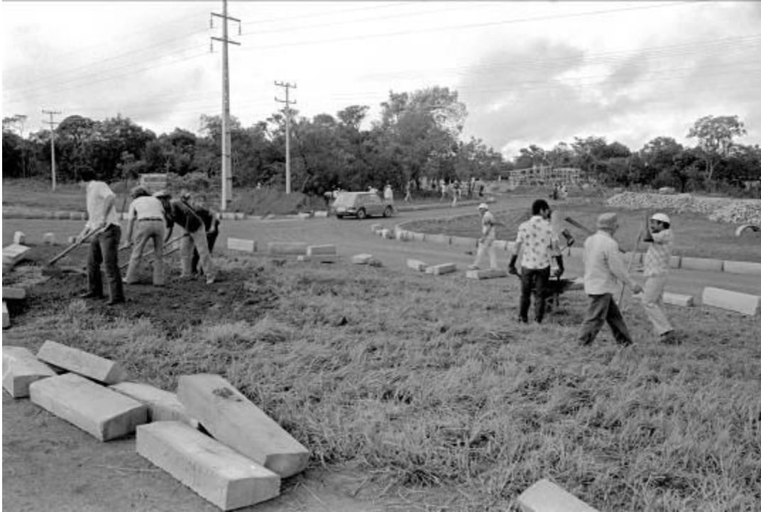
Figura 21 - Construção do Portão Principal do Jardim Botânico de Brasília e urbanização da interface com a Estrada Parque Cabeça de Veado (Fotografia de Rui Faquini).
