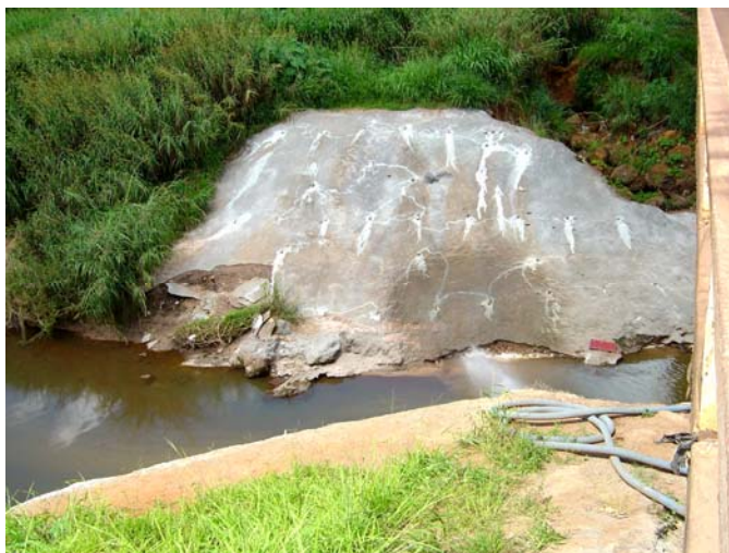
Figura 38: Margem do Ribeirão Taguatinga, sob a ponte que liga o NRT à Ceilândia, durante as obras de contenção das margens, a fim de evitar maiores desbarrancamentos na época das chuvas.
