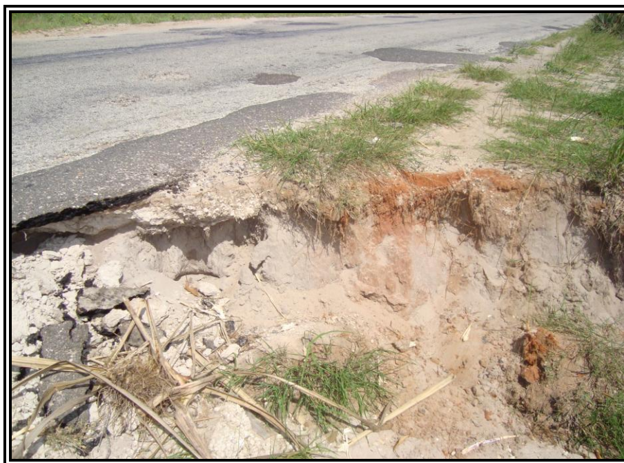
Figura 16 – Estrada que dá acesso a zona turística costeira ameaçada pela erosão Fonte: autor, 2009
