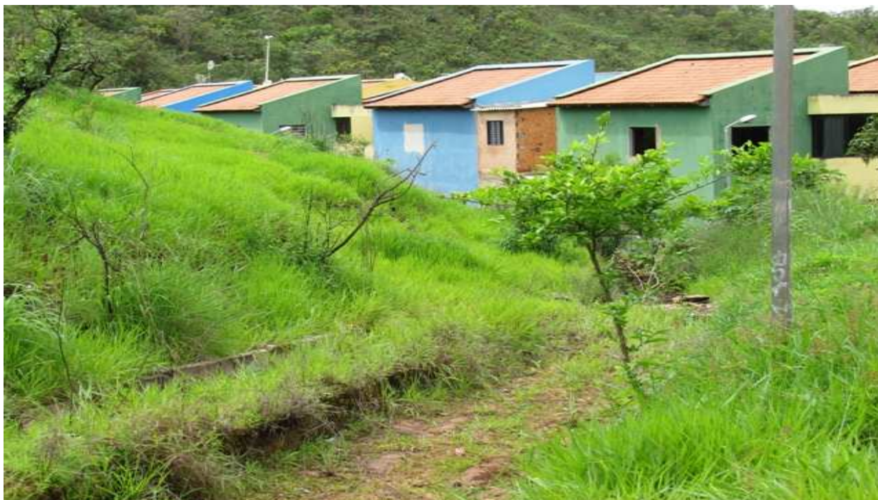
Fotografia 3 – Canaleta para escoamento de água das chuvas na quadra 5 do Varjão (DF)
