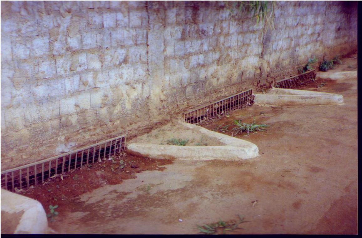
FIGURA 32: Bocas de lobo para águas pluviais
