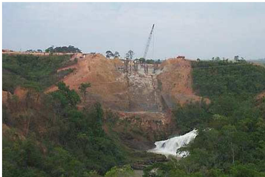
Figura 33 – Interrupção da cachoeira do Queimado e desvio do Rio Preto
