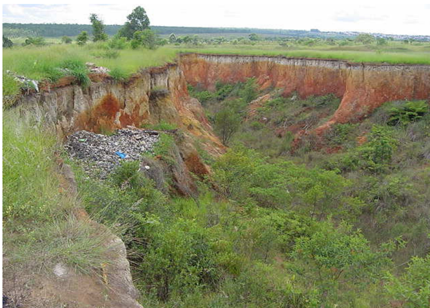
Figura 39 - Voçoroca na área de drenagem do Rio das Pedras na bacia do Lago Descoberto
