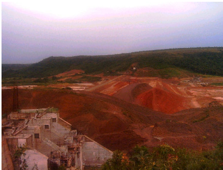
Figura 07 - Usina hidrelétrica Corumbá IV em construção na bacia do Lago Descoberto
