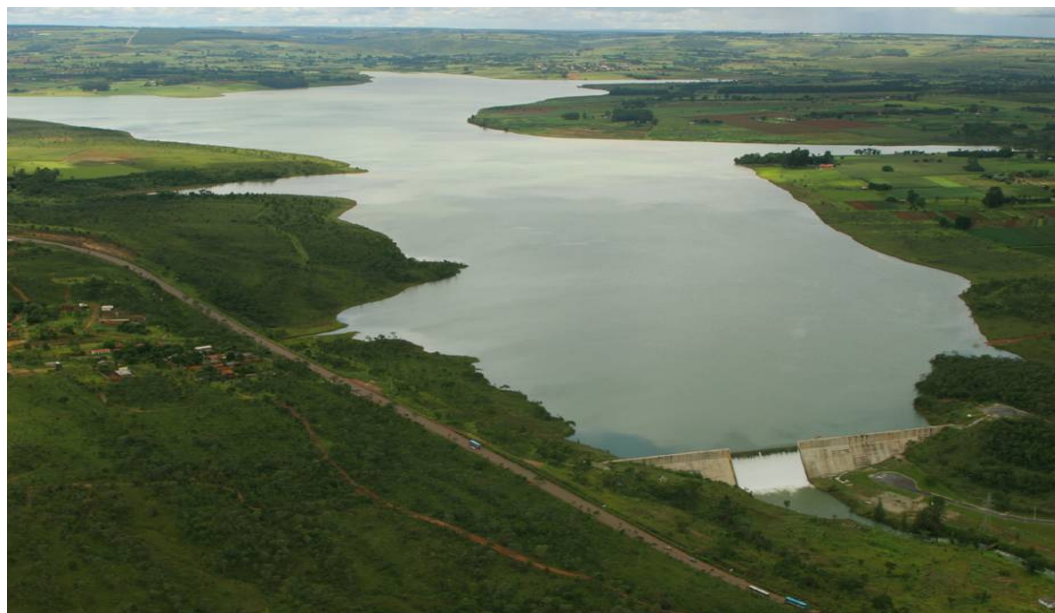
FIGURA 41 - BARRAGEM DO RIO DESCOBERTO
