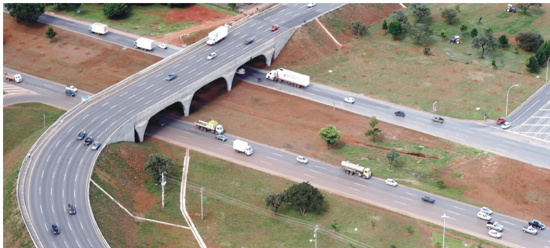
FIGURA 42 - VIADUTO DA RODOFERROVIARIA
