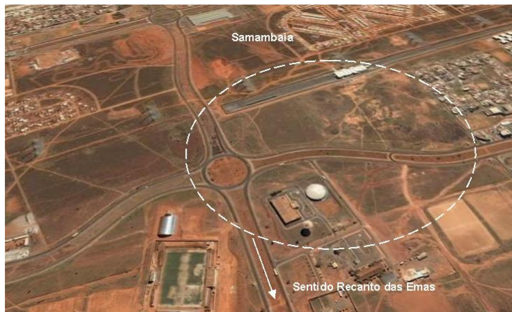
FIGURA 110 – PÓLO MULTIFUNCIONAL SAMAMBAIA
