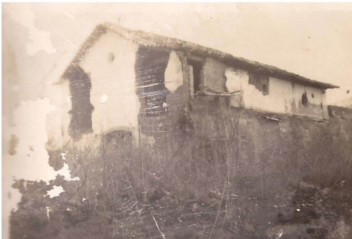
Figura 028 - Igreja de Ouro Fino destruída em meio ao Cerrado, diluindo aos poucos – Acervo de Bento Fleury.
