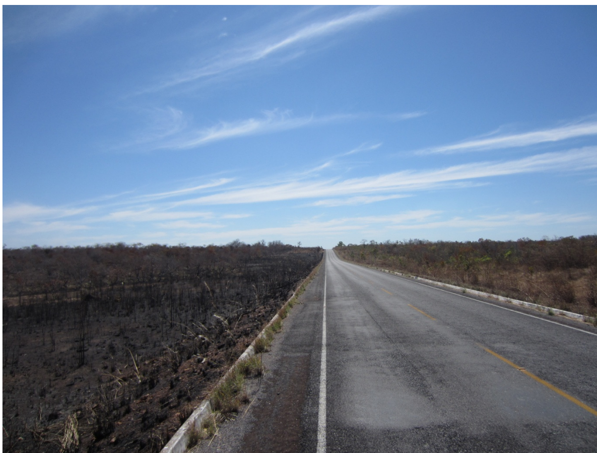
Figura 7 – Queimada. Estrada TO 050, proximidades de Porto Nacional (TO), 2012. Foto do autor.
